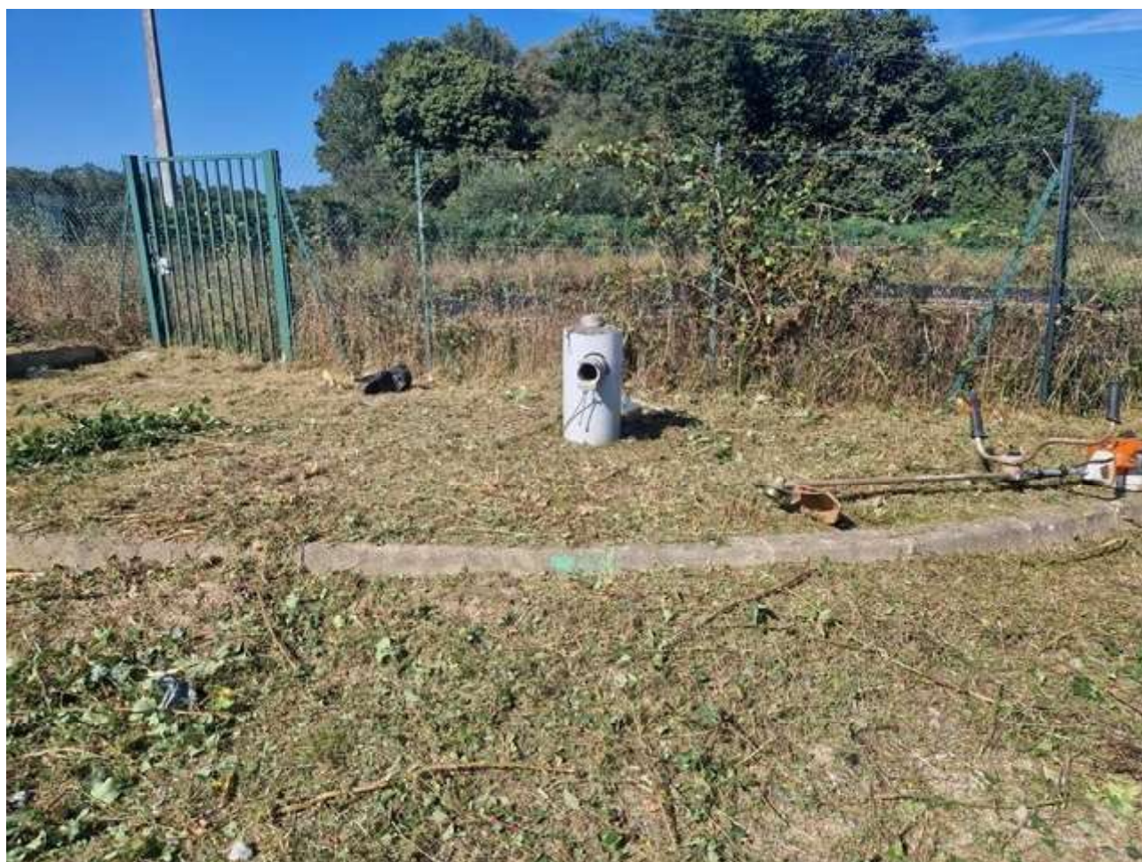
Prise d'eau de la deuxième réserve incendie totalement débroussaillée à la suite du sinistre du 21 août 2023 et opérationnelle
