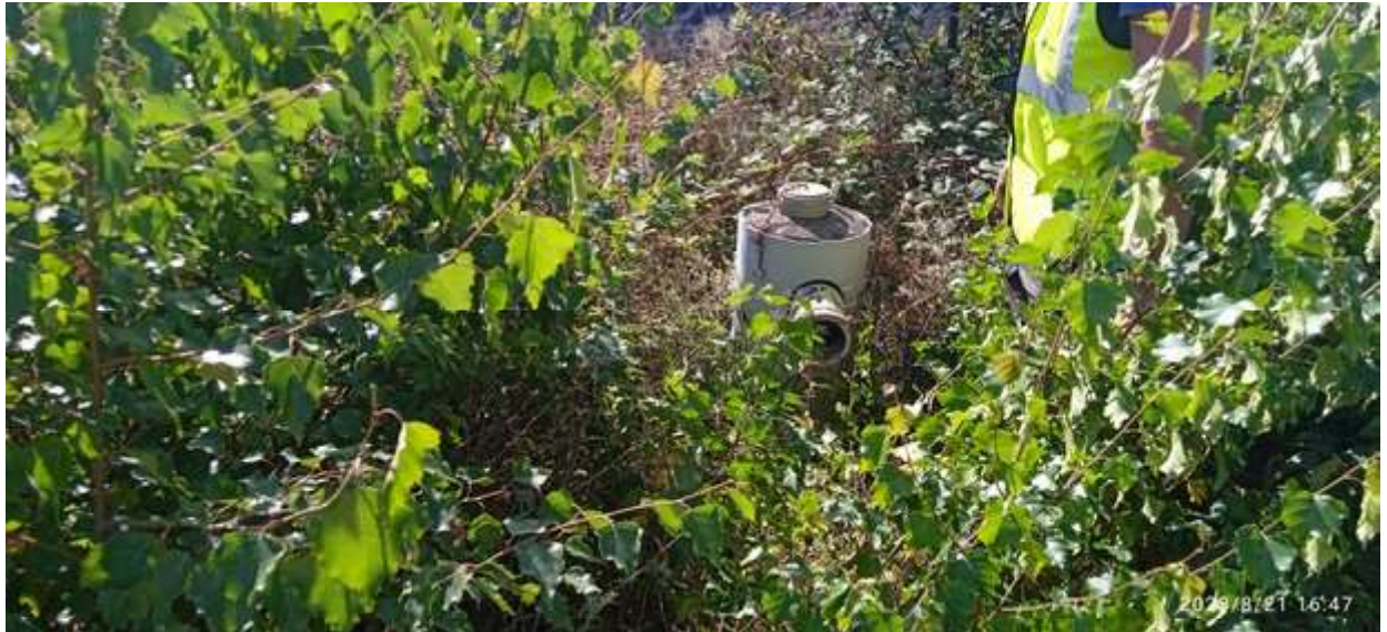
Prise d'eau de la deuxième réserve incendie envahie par la végétation et de ce fait inutilisable
