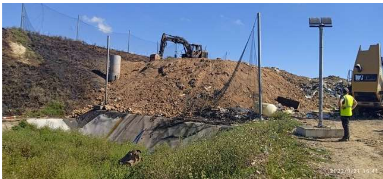
Diguette impactée par le sinistre incendie. Une partie a été recouverte par de la terre afin de faciliter l'extinction
